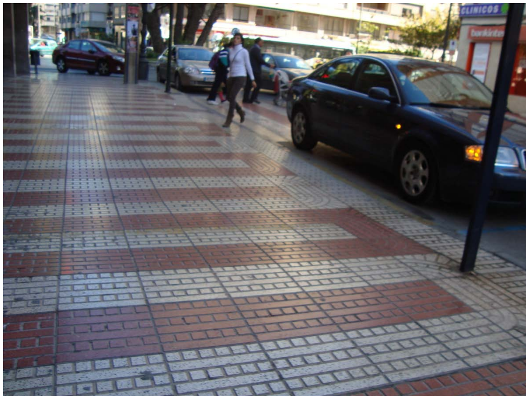
Fotografía 4 – Zona acumulación pluviales.
