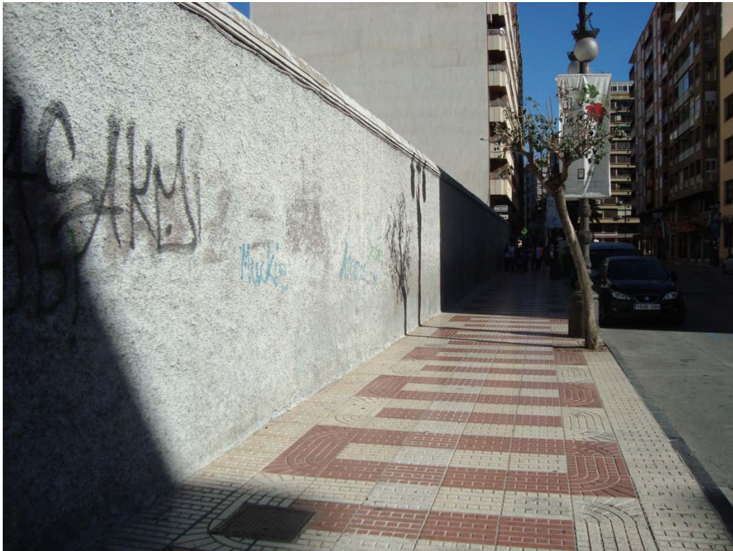
Fotografía 3 – Muro Convento San Sebastian.
