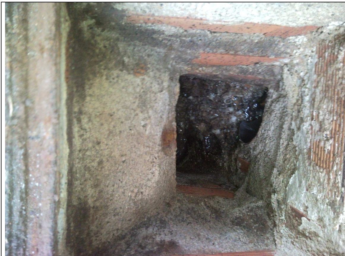
EN PARTE IZQUIERDA REVOQUE DE MORTERO PROTEGIENDO TUBERÍA DE FIBROCEMENTO DE AGUA POTABLE EN ARQUETA DE SANEAMIENTO
