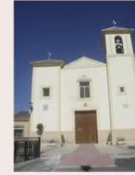
Iglesia Ntr. Sra. del Remedio
