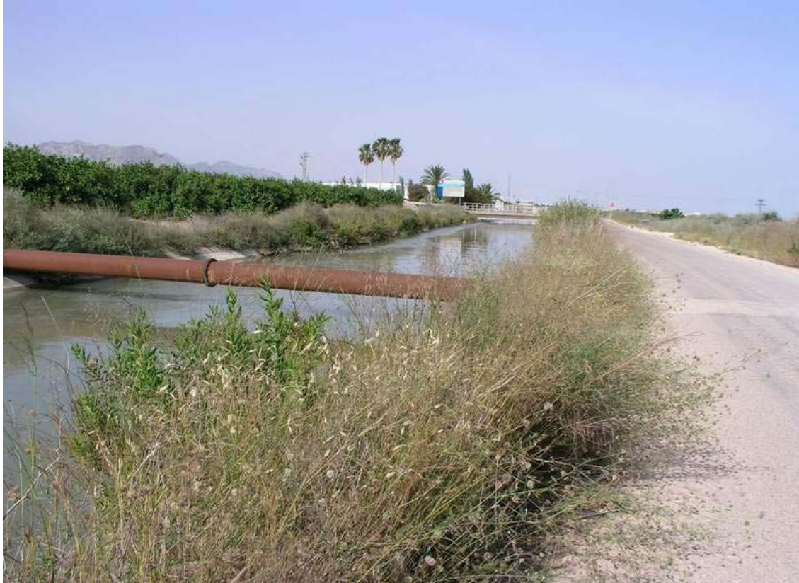
Foto 5: Vista del canal del Traslase desde la carretera de servicio en las inmediaciones de la obra. Al fondo estación de Bombeo de la Mancomunidad de Canales del taibilla.
