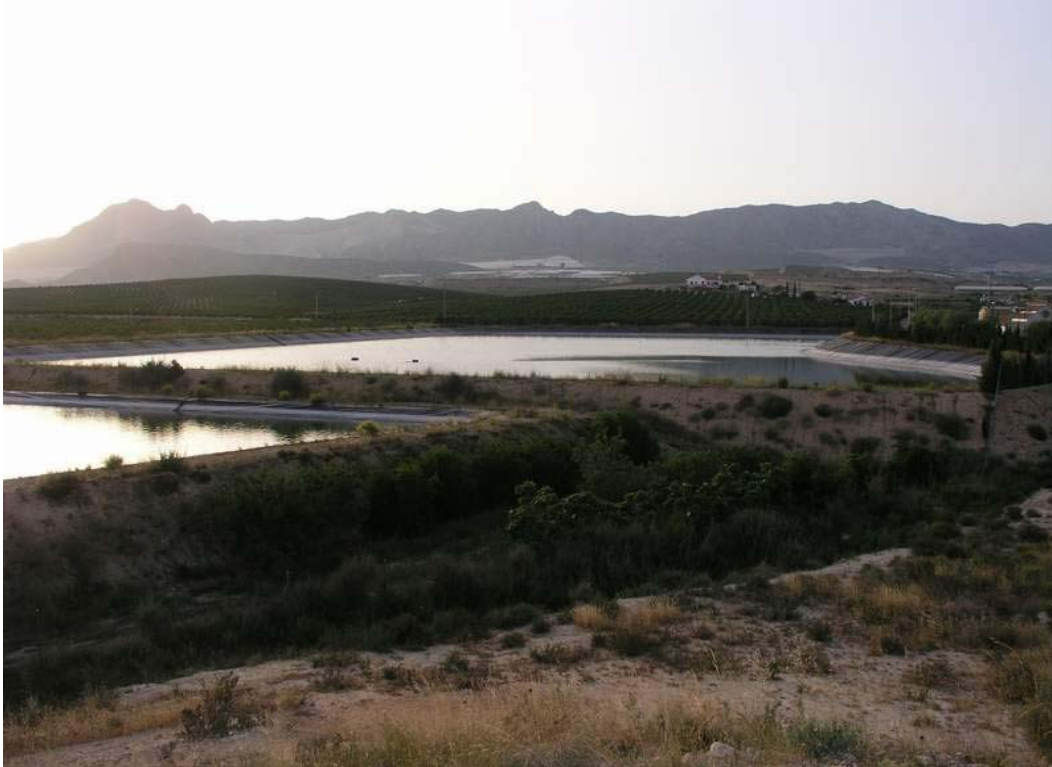
Foto 4. Las balsas de riego hoy generalmente aparecen cercadas y se impermeabilizan mediante lámina plástica
