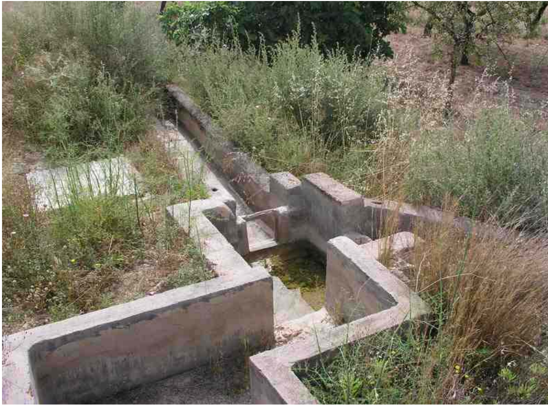
Foto 2. Infraestructuras de conducción típicas del sistema tradicional de riego "a manta" por gravedad
