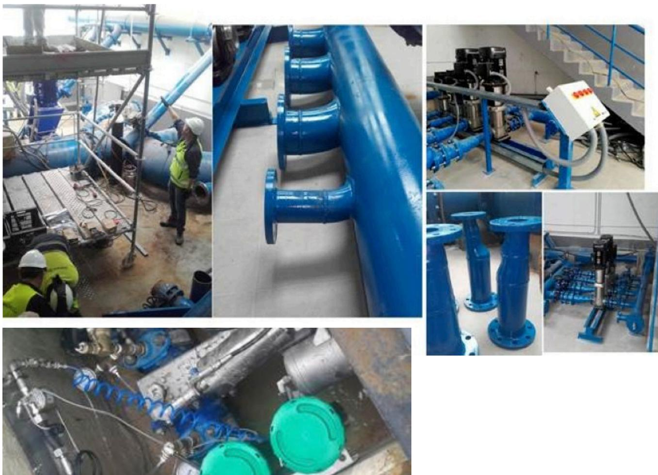
*Renovación de la EBAP El Canal: sustitución de bombas, adaptación de calderería, obra civil y modificación scada.*
